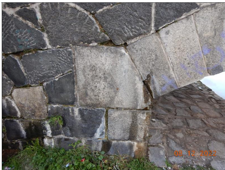
Detail levé strany O4 - vypadané spárování (do velké hloubky), stopy zatékání, výluhy pojiva, uchycená vegetace.
