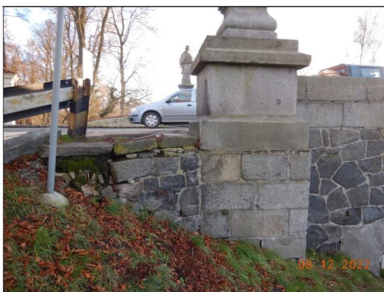
Detail pravého křídla na O1, křídlo je vykloněné na konci rozpadlé.
