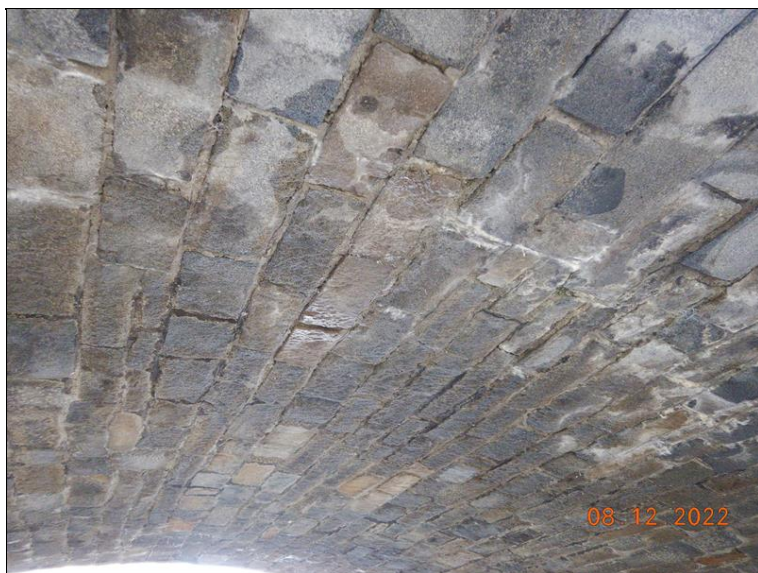
Detail výluhů a krápníků na levé straně pole č. 3 (pohled proti směru staničení). Obdobný stav je i na pravém kraji konstrukce.
