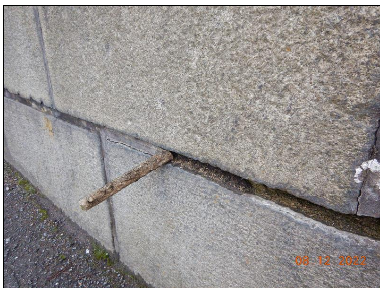
Pohled na ocelový prvek vyčnívající ze spáry levé zábradlní zídky (v poli č. 1).
