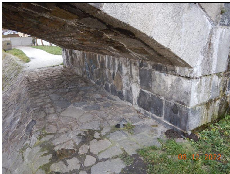
Pohled na O4, stopy zatékání a velké množství výluhů.
