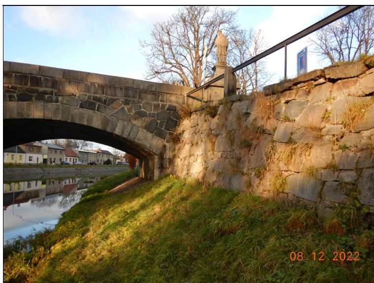
Pohled na nábrežní zeď navazující na O1. Kameny ve zdi prakticky bez spárování, některé uvolněné, velké množství uchycené vegetace.
