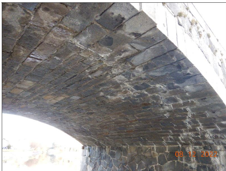
Pole č. 3 (pohled proti směru staničení). Stopy zatékání ve vrcholu klenby a na levé straně, výluhy pojiva tvořící krápníky.
