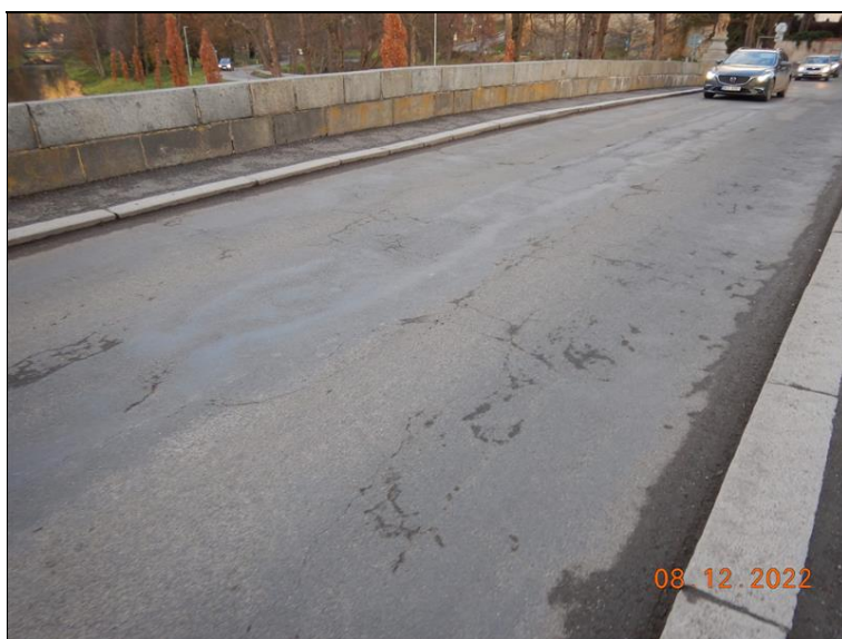
Pohled na vozovku na mostě, množství trhlin, celkově nerovnosti na celém povrchu.
