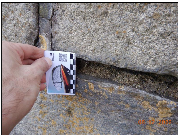
Detail vypadaného spárování kamenné zábradelní zídky.
