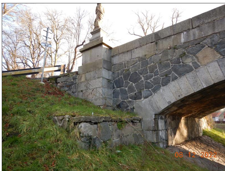
Pohled na pravé křídlo O1. Krátká kamenná zeď navazující na O1, toto zídka je značně rozvolněná.
