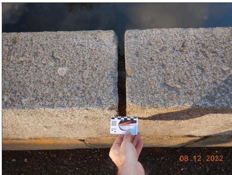
Detail otevřené spáry bez spárováním v horním líci zábradelní zídky (na pravé straně).
