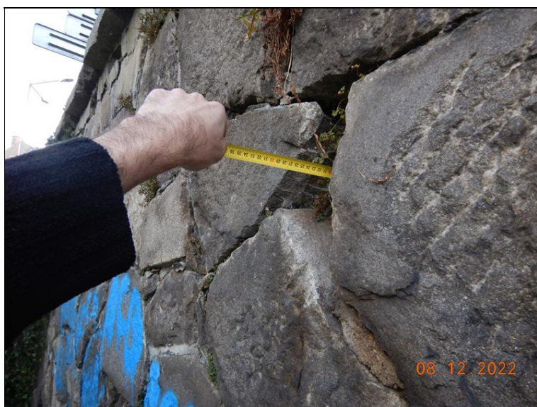
Detail kaverny v křídle - spárování je celoplošně poškozené až vypadané. 2/2
