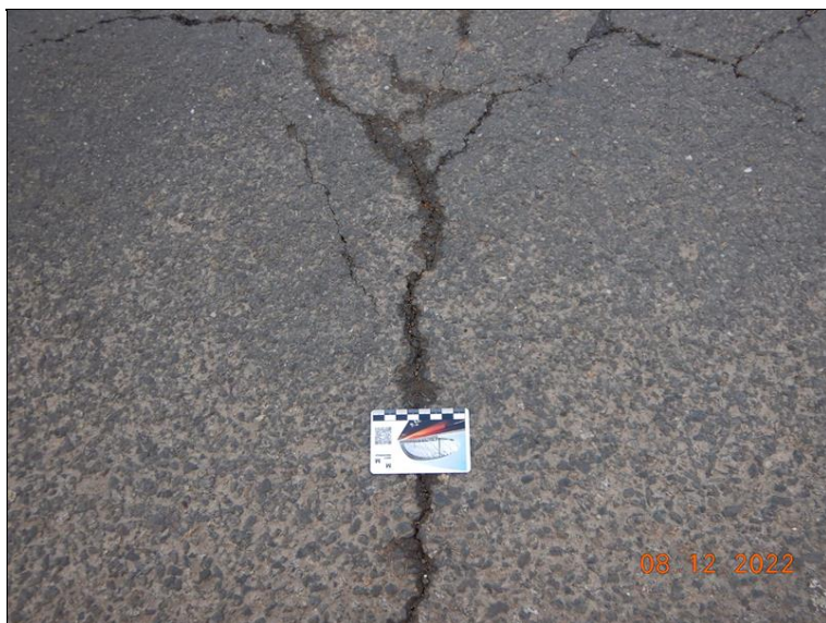
Detail trhlin v živičném povrchu.
