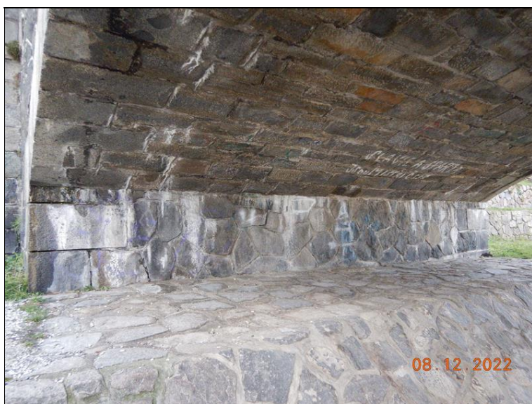
Pohled na O4, stopy zatékání a velké množství výluhů (na krajích jsou stopy zatékání silnější).
