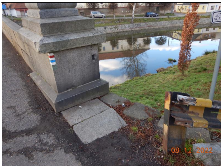
Chybějící část zábradlí a na O1 na pravé straně.
