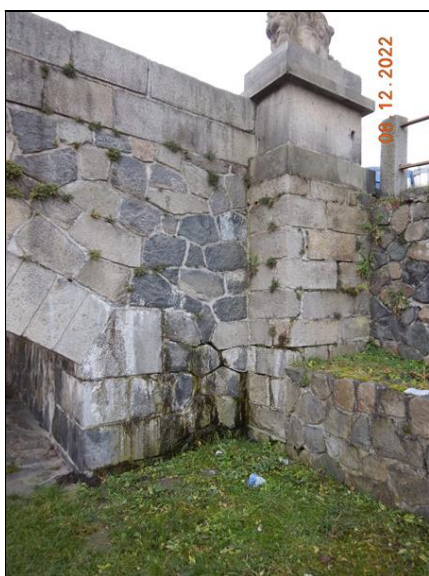
Detail pravé strany O4 - vypadané spárování (do velké hloubky), stopy zatékání, výluhy pojiva, uchycená vegetace.
