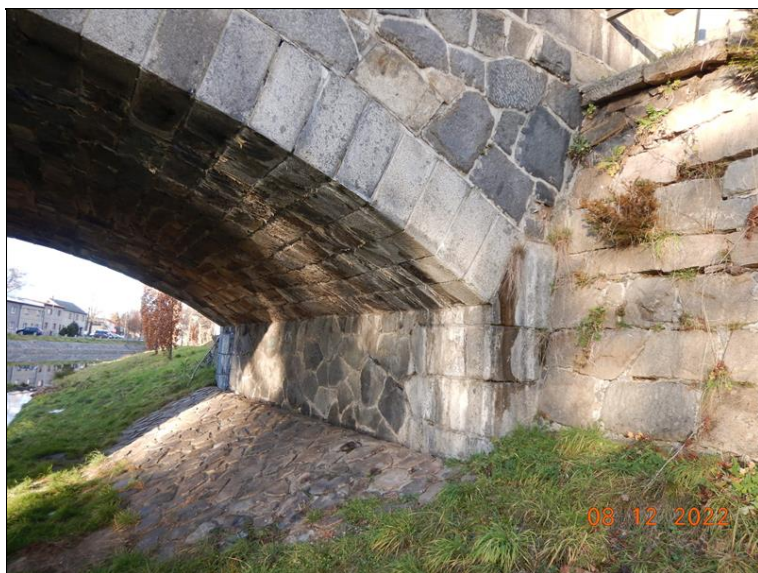
Detail opěry O1, stopy vytékání vody z místa uložení klenby (na levé straně).
