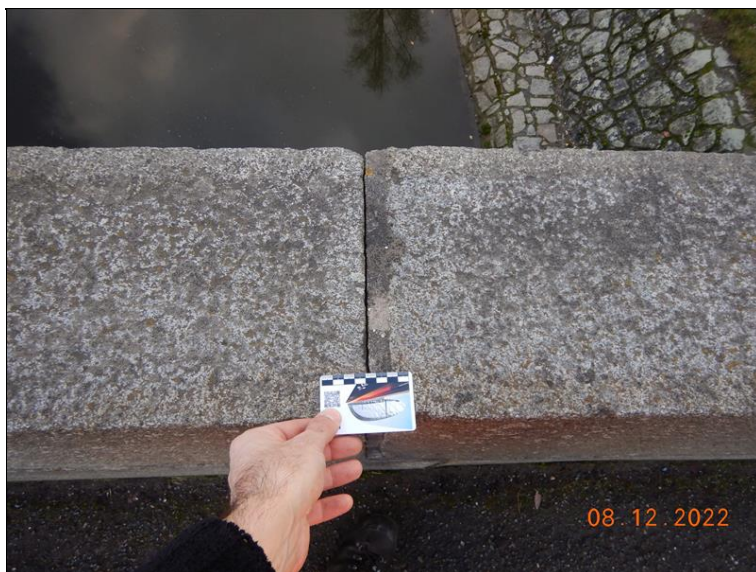
Detail otevřené spáry na horním líci zábradlní zídky.
