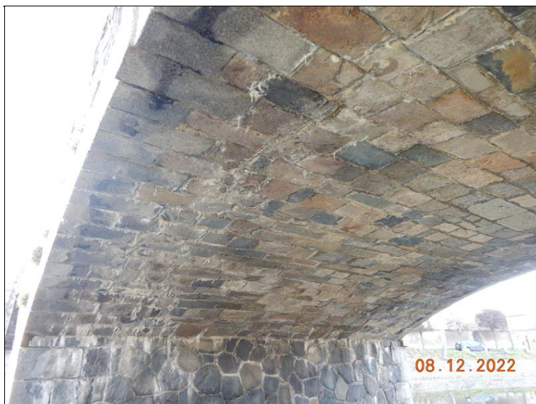
Detail na napojení nábrežní zdi na opěru O1 na levé straně. Kameny ve zdi prakticky bez spárování, některé uvolněné, velké množství uchycené vegetace.
