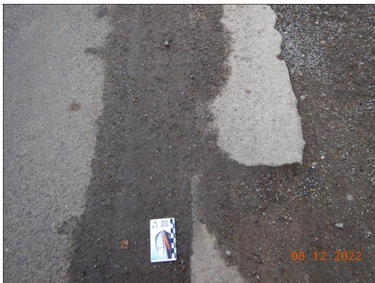
Detail obrubníku, nízká výška, lokálně propadlé kamenné obrubníky.
