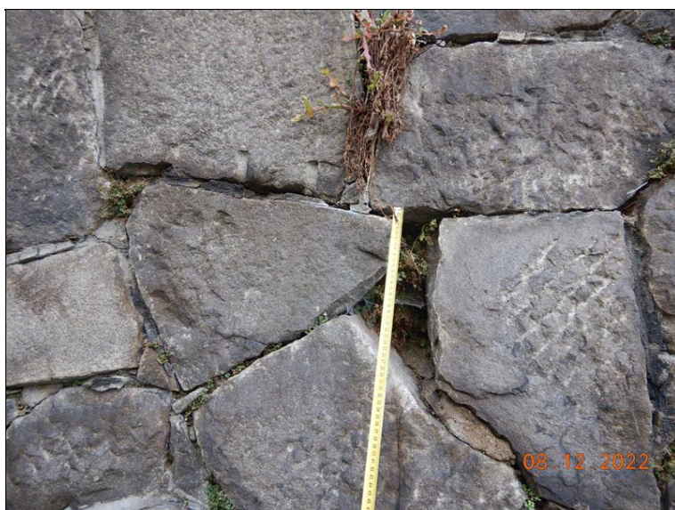
Detail kaverny v křídle - spárování je celoplošně poškozené až vypadané. 1/2
