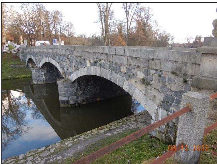
Detail pravé strany O4 - vypadané spárování (do velké hloubky), stopy zatékání, výluhy pojiva, uchycená vegetace.
