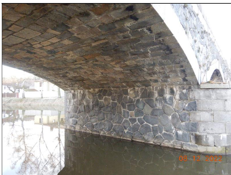
Detail výluhů a krápníků na pravé straně pole č. 1 (pohled proti směru staničení).
