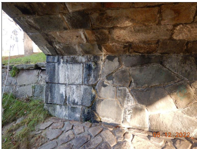
Silné zatékání na pravé straně O1.
